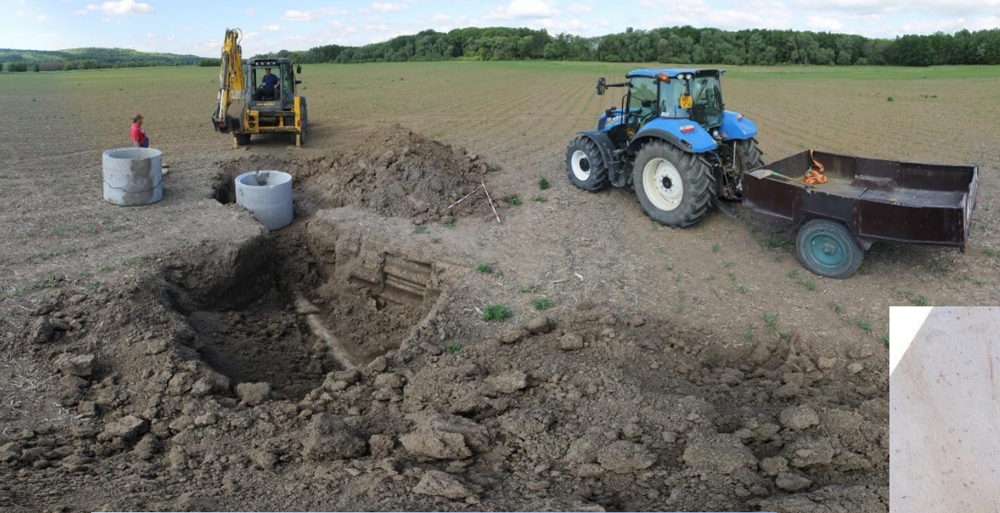
instalace kontrolní šachtice v poli
